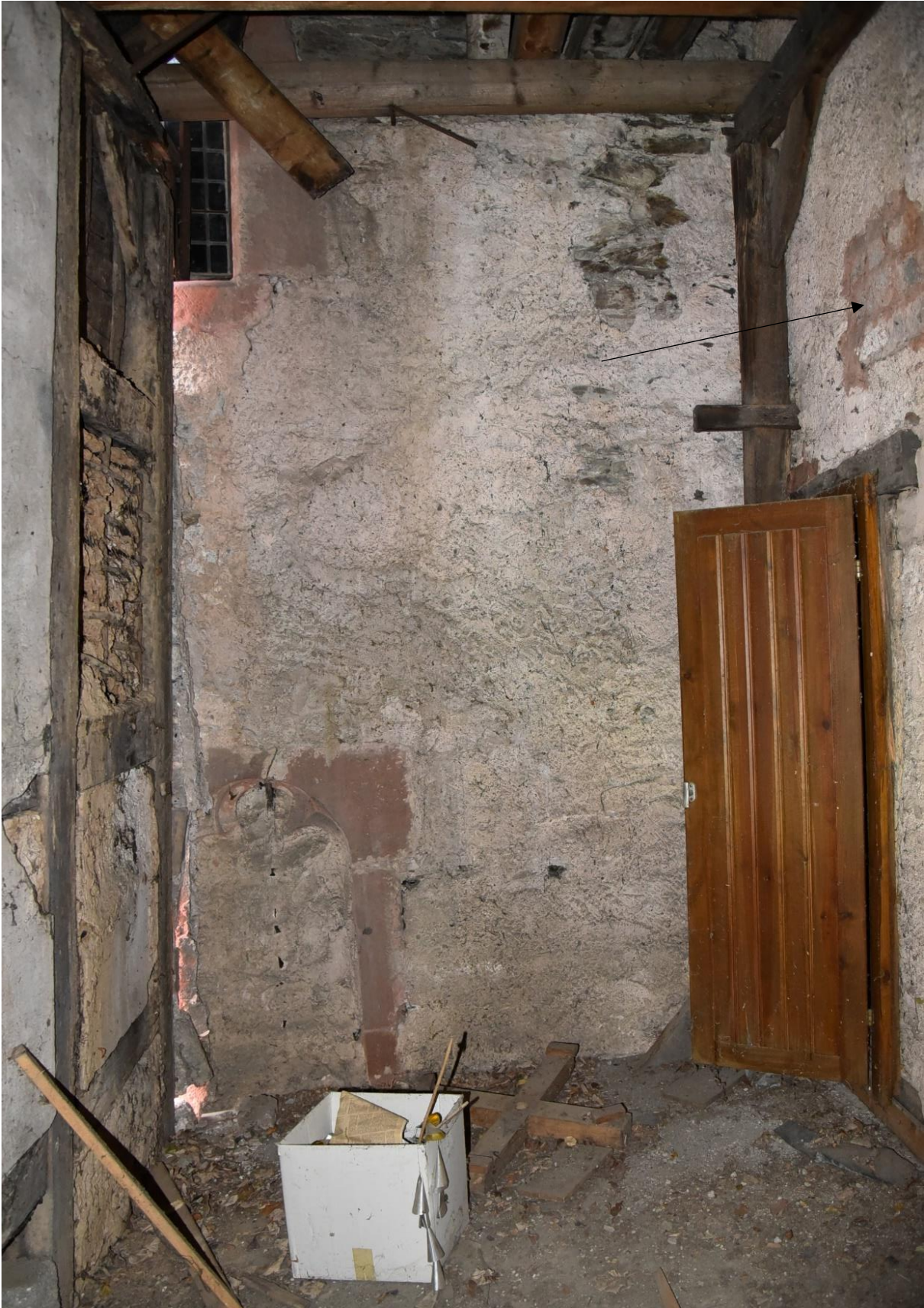
Balghaus, Blick zur Sakristeiwand, oben rechts der zugemauerte Kanaldurchgang
