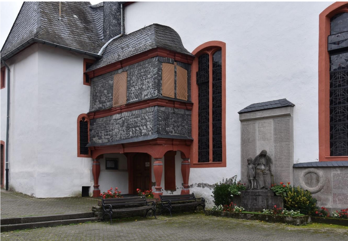
Das originale Balghaus, als Fachwerkkonstruktion mit Schieferverblendung von 1763
