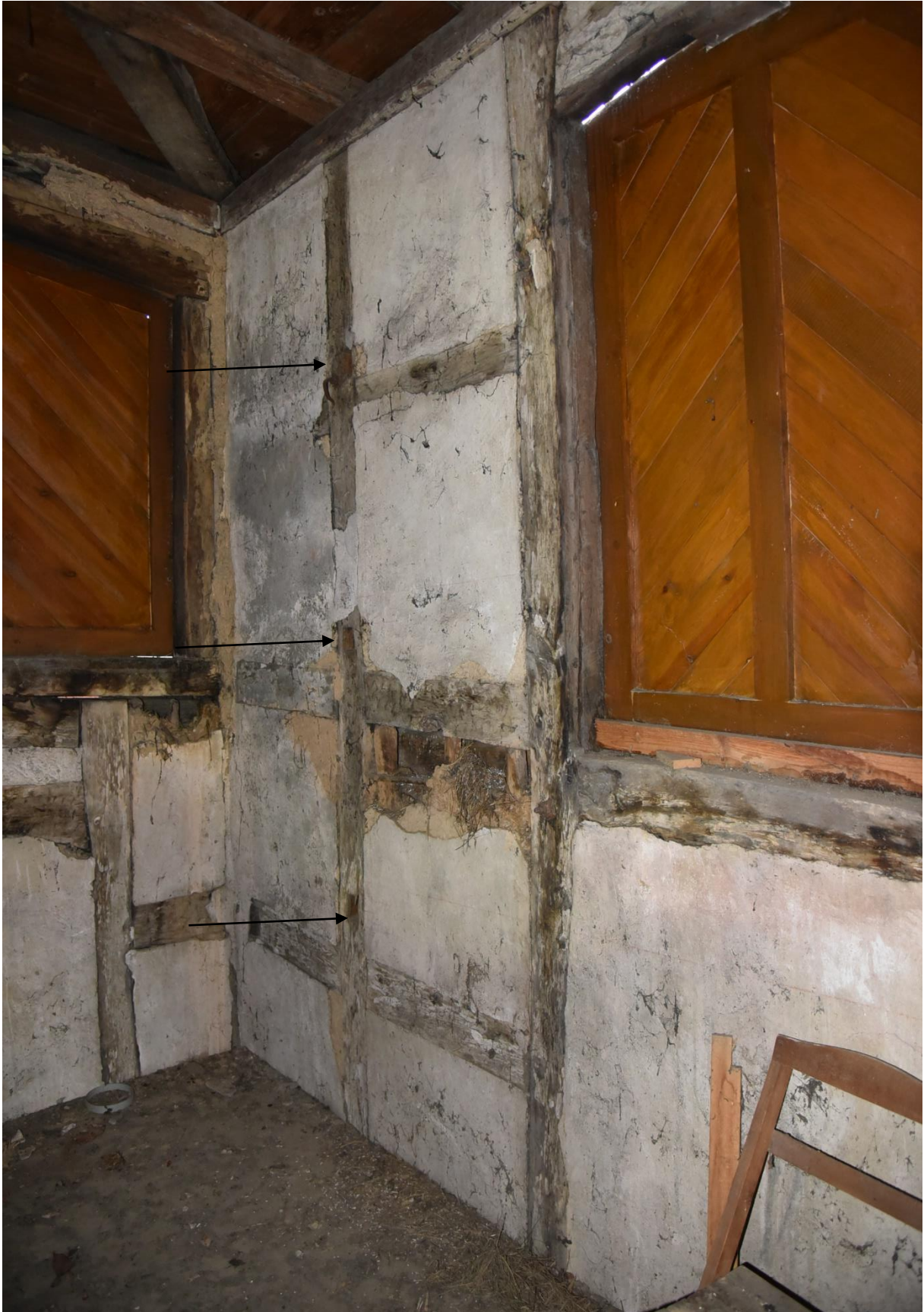
Balghaus, hier Blick in die Gegenrichtung: angezeigt die Ausstimmungen für die Lagerhölzer der 3 Keilbälge
