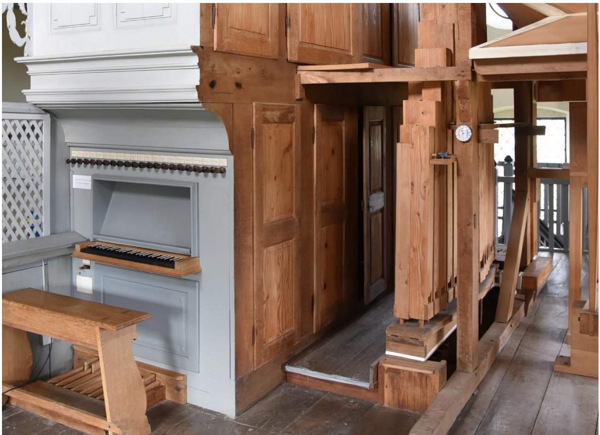
Spielanlage in Kleinich, Ev, Kirche, 1809 gebaut – hier mit Gehäuserückwand, Pedallade und – angeschnitten - die hinterständige Balganlage.
